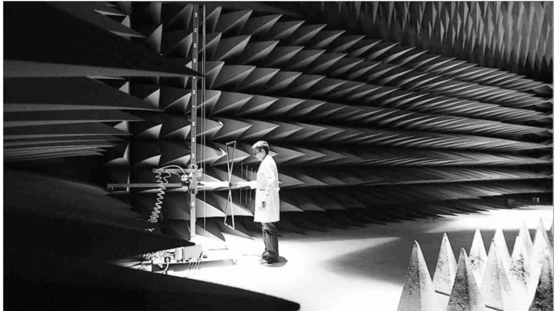
Cámara semianecoica de la empresa Cetecom, dentro del Parque Tecnológico de Andalucía, en Málaga.
