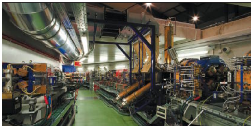
Edificio del sincrotrón Alba, en Barcelona (arriba), y la gran máquina que alberga en su interior. / CELLS
