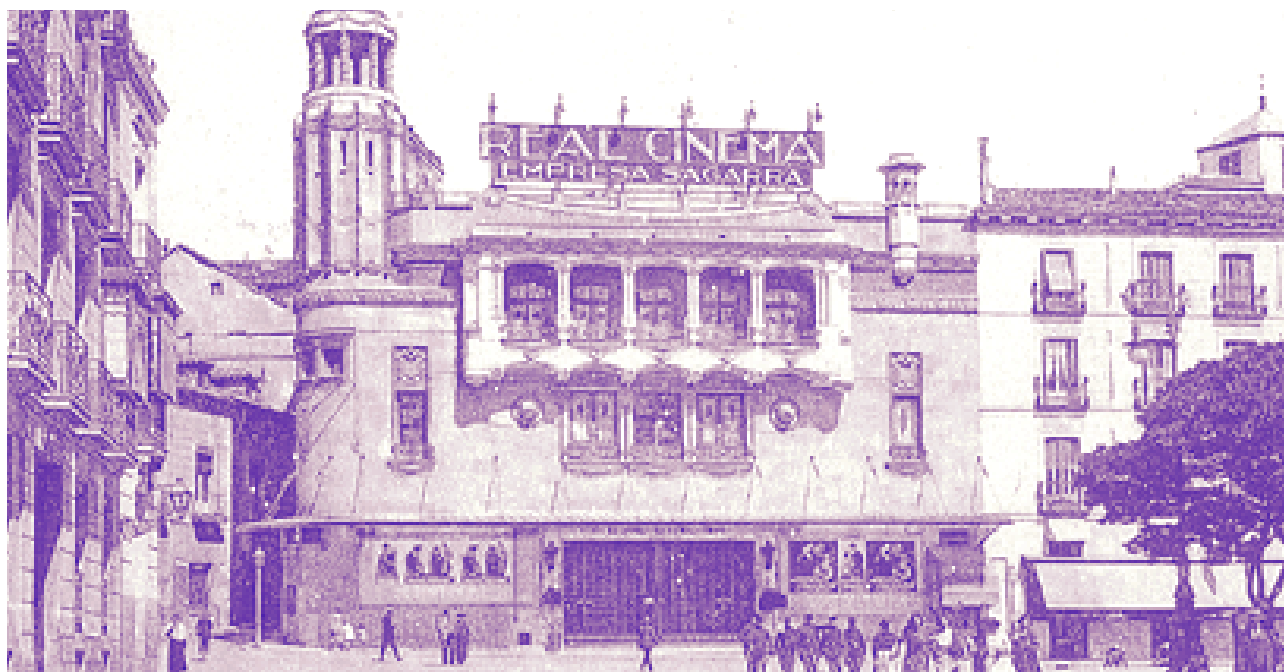
Real Cinema. Fachada principal (1918).
