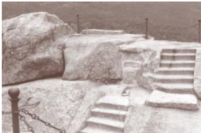
Vista lateral de la "silla", donde se aprecian grandes restauraciones
