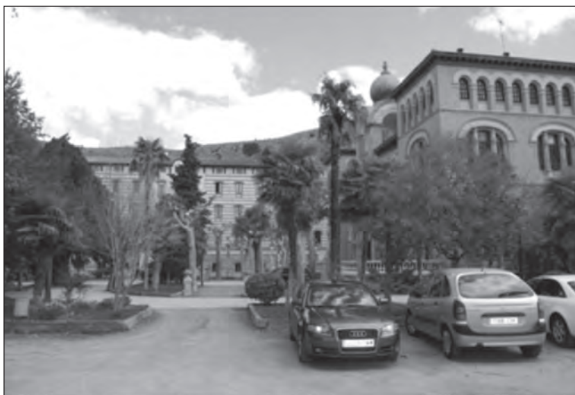
Figura 9. Vista parcial de las instalaciones de Termas Pallarés con el teatro-casino a la derecha.
