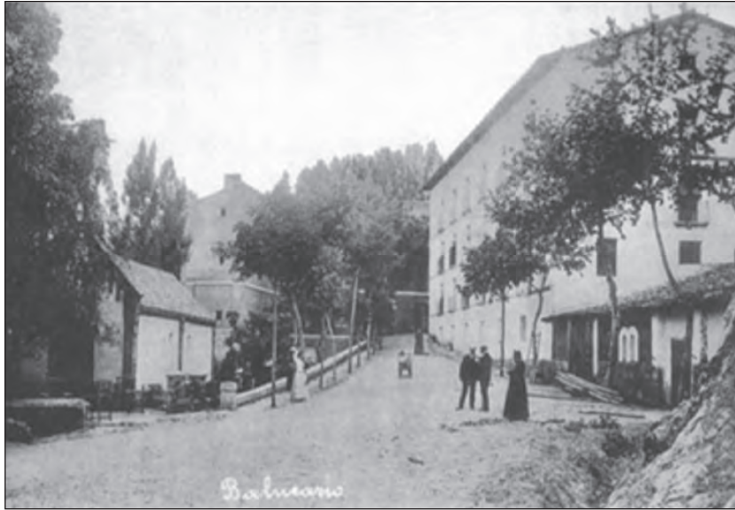
Figura 17. Antigua edificación del Balneario Sicilia (Jaraba).
