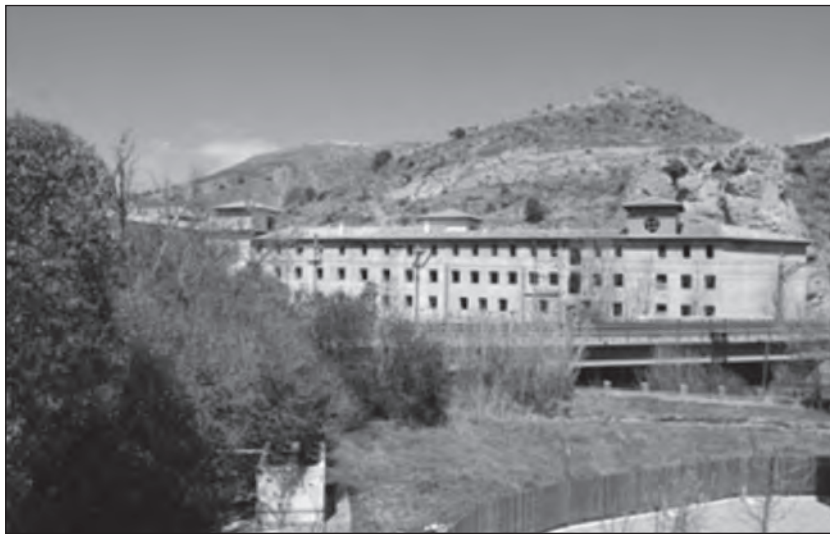
Figura 11. Vista de conjunto del Balneario Guajardo, actualmente en proceso de rehabilitación. Fuente: Trabajo de campo, 2012.
