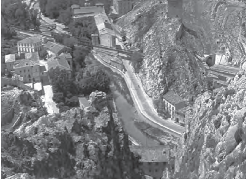
Figura 6. Vista de conjunto de los balnearios de Alhama de Aragón.
