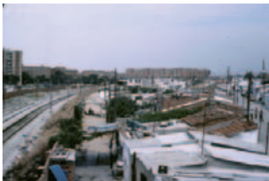
Figura 5. Deficiente calidad constructiva y ambiental del asentamiento chabolista de Palomeras Bajas, separado de Entrevías por el ferrocarril Madrid-Zaragoza.
