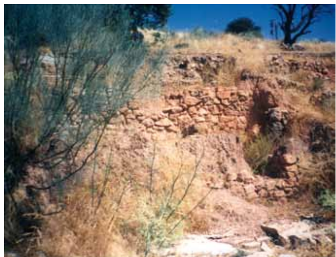
Fig. 3. Degradación de las estructuras excavadas en los ochenta a mediados de los años noventa.
