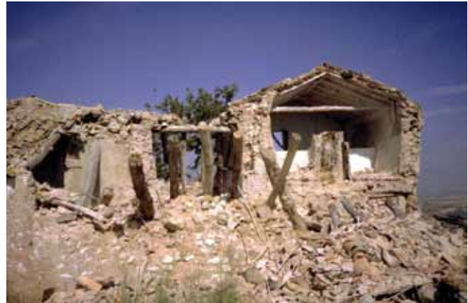
Fig. 15. Derrumbe de una casa tradicional de campo en la provincia de Córdoba. El estudio de la decadencia y caída de estas estructuras es de mucha utilidad al arqueólogo.
