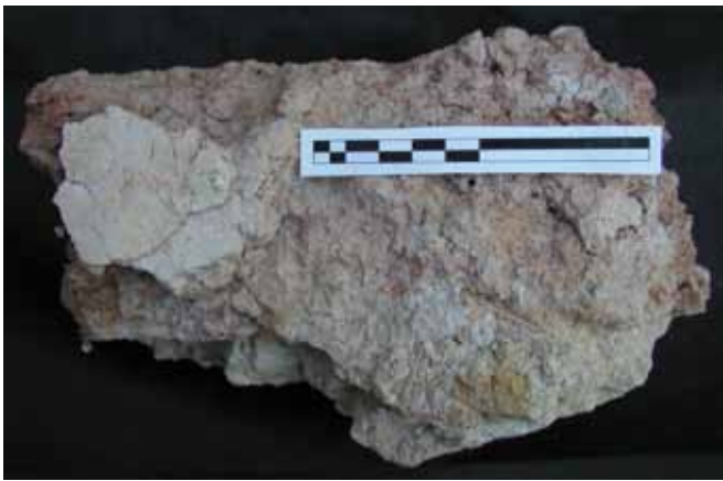
Fig. 8. Restos de enlucido en una pared del poblado.
