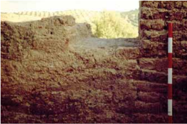
Fig. 3. Muro de adobe excepcionalmente bien conservado, con el marco de una ventana, en la parte trasera de una estancia en el Cerro de la Cruz (campañas de 1987-1989).
