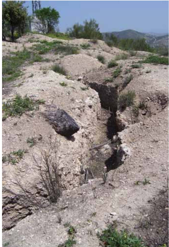
Fig. 21 Trazado de las trincheras del Cerro de la Cruz que serán museizadas en un futuro próximo.
