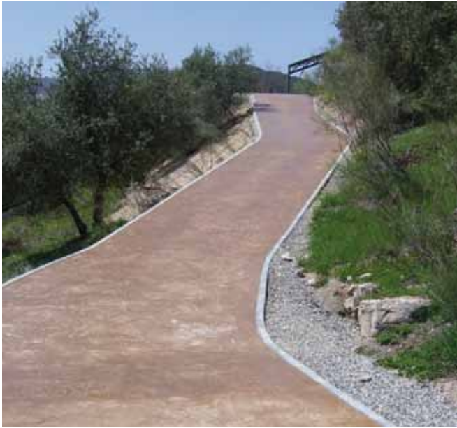
Fig. 9. Caminos de acceso interior al yacimiento acondicionado para minusválidos.
