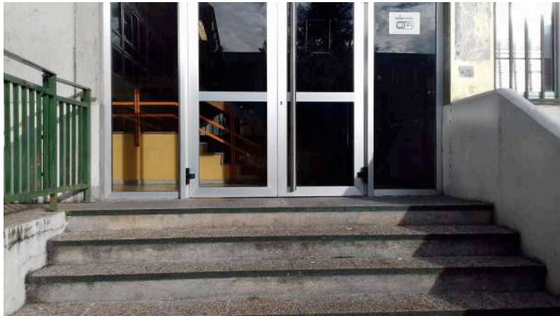
Foto 3. Tramo segundo de la escalera vista frontal con puerta acceso cafetería
