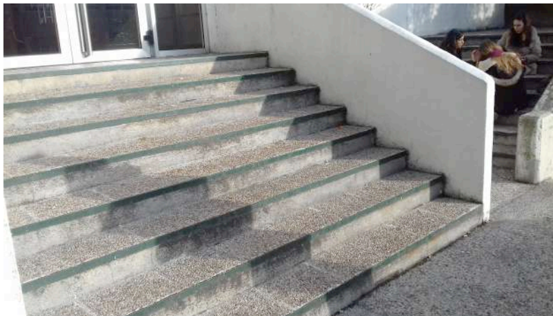
Foto 2. Tramo segundo de la escalera vista lateral
