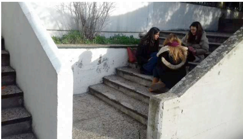
Foto 4. Tramo acceso a terraza situada a la derecha de la puerta
