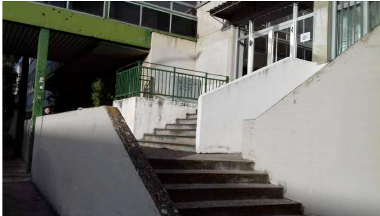
Foto 1. Tramo inicial de la escalera
