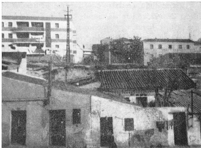
Fig. 6.—Vista parcial del barrio. En primer término, calle del Arroyo de las Morenas (zona chabolística). Al fondo, dos muestras de la renovación del barrio: a la derecha, construcciones de promoción municipal, y a la izquierda, inmueble de financiación privada
